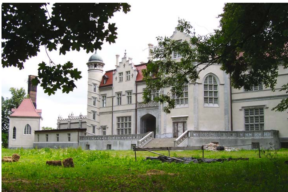
Il. 5. Pałac w Jabłoniu, elewacja ogrodowa. Fot. A. Cebulak, lipiec 2006.
